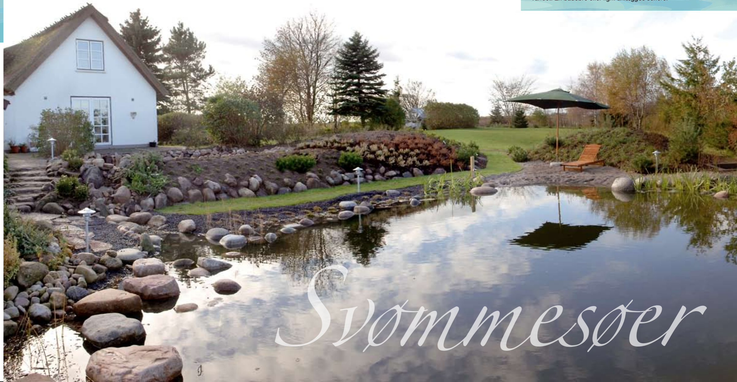
Her ses en af Danmarks første svømmesøer. Søen er nyanlagt, beplantningen mangler derfor at etablere sig. Anlægget består af et nedre bassin med et dybt svømmeområde i midten og en lav bredzone med vegetation og dekorationssten i kanten. Her ses trædesten i vandet og en sandstrand er anlagt til afslapning og som adgangszone til vandet. En badebro eller lign. anlægges senere.
