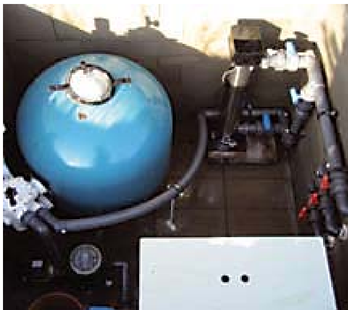
En teknikstation bestående af et mekanisk sifilter nederst til højre, en tømmeret pumpenederst til venstre og et Beadfilter øverst til venstre. Øverst til højre ses et UV-lys til at bekæmpe sygdomsfremkaldende vira og bakterier. I midten til højre ses tre returløb, hvorfra vandet ledes tilbage til svømmesøen. Teknikstationen kan skjules f.eks. under en træterrasse.
